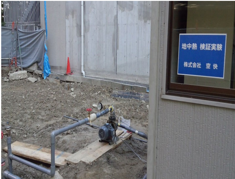
地下 16mに地中熱交換器
